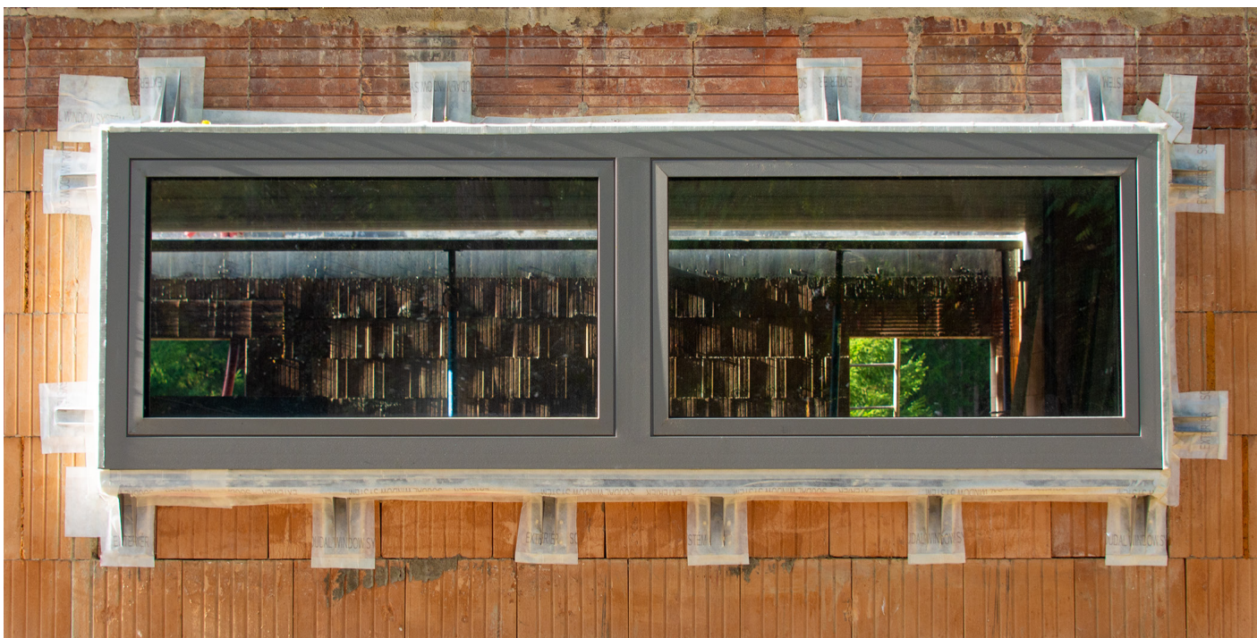
Příklad zabudovaného okna systémem předsazené montáže WIN-ROCK - pohled z exteriéru
