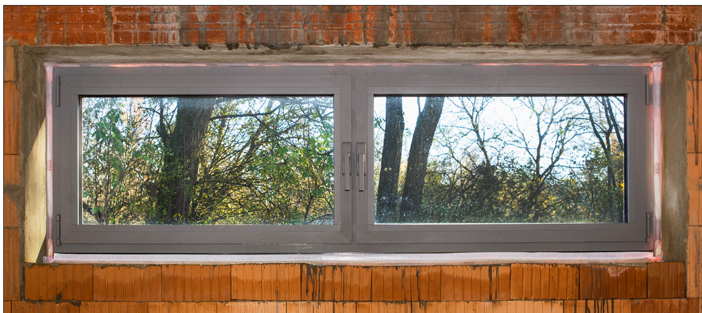
Příklad zabudovaného okna systémem předsazené montáže WIN-ROCK - pohled z interiéru
