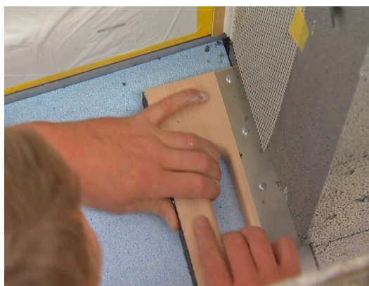
Příprava lůžka pro SOL-PAD - naříznutí a vybroušení kapsy
