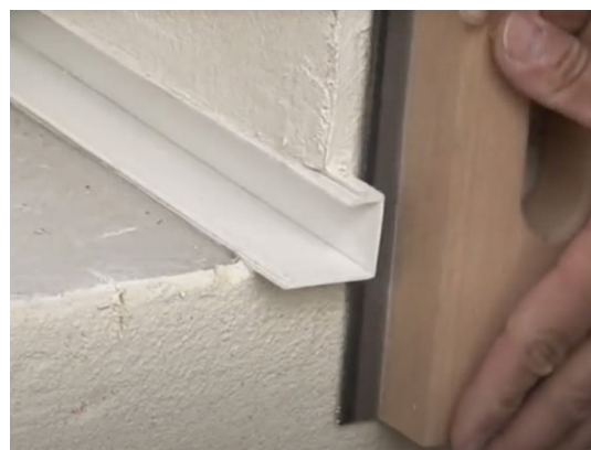
Zařízení přesahující části profilu SOL-PAD
